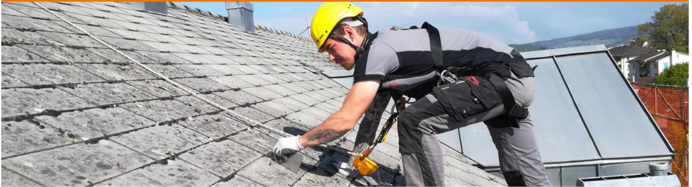
Reinigung von Plattenfugen bei nicht asbesthaltigem Faserzement
