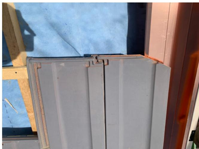
*Seitlicher Anschluss bei geschuppten Deckmaterialien mit Seitenblech und gestutztem Ecken*
