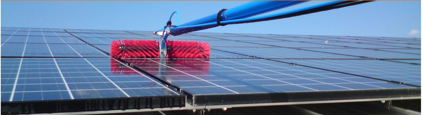
*Saubere Solarmodule tragen dazu bei, dass die Solaranlage optimale Einträge liefert*
