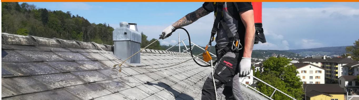
Aufsprühen des biologischen Reinigers. Generell sind bei Arbeiten auf Dächern Absturzsicherungen an den Dachkanten (Traufe, Ort), sowie der Schutz vor Stürzen durch das Dach vorgeschrieben.
