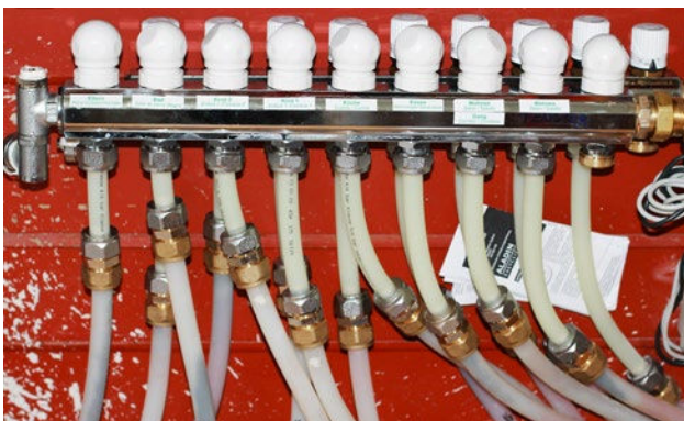
Neuer Fussbodenheizungsverteiler nach der Spülung/Reinigung
