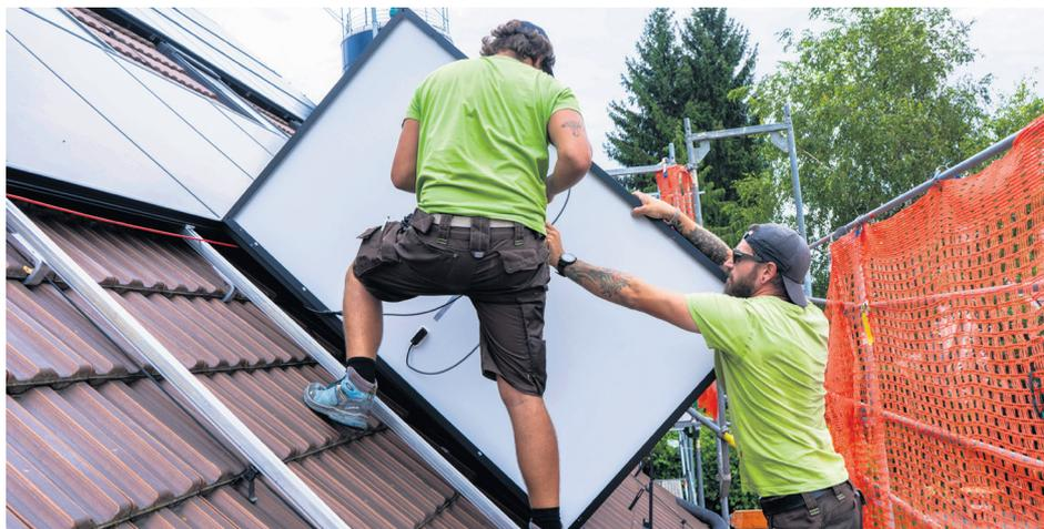
Für Solarinstallateure heisst es jeden Tag aufs Dach. Während der Bauphase steht ein Baugerüst für die Arbeitssicherung.
